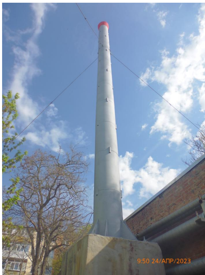
Ремонт дымовой трубы котельной ул. Инструментальная,15-8
