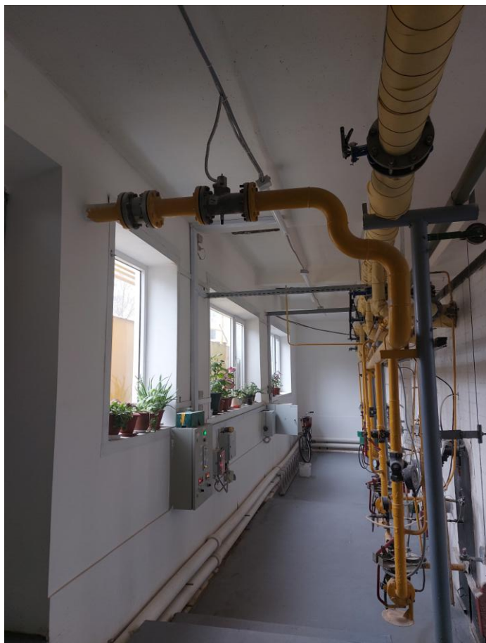
Ремонт здания котельной ул.Р.Люксембург,52а
