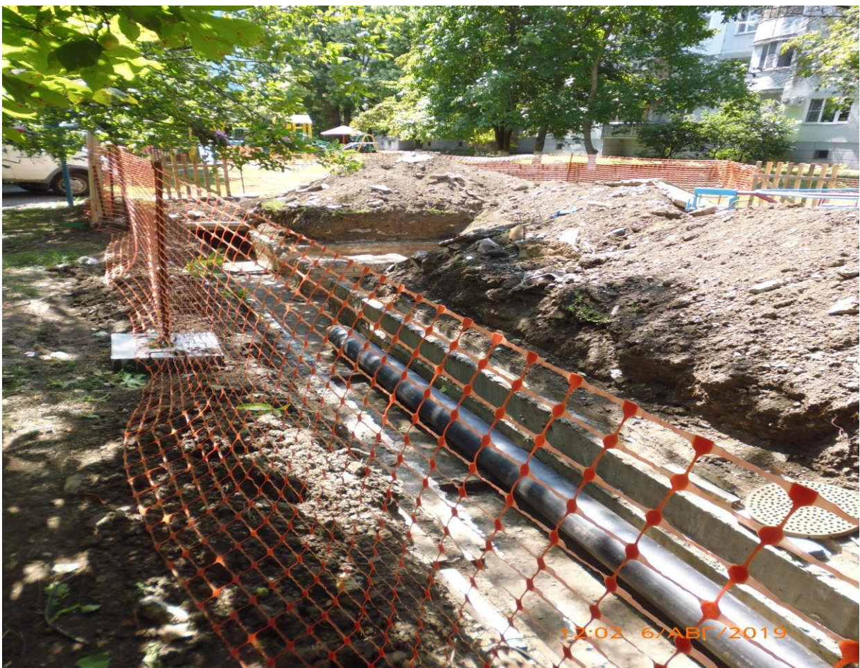
Ремонт теплотрассы от котельной по ул.Л.Чайкиной,23
