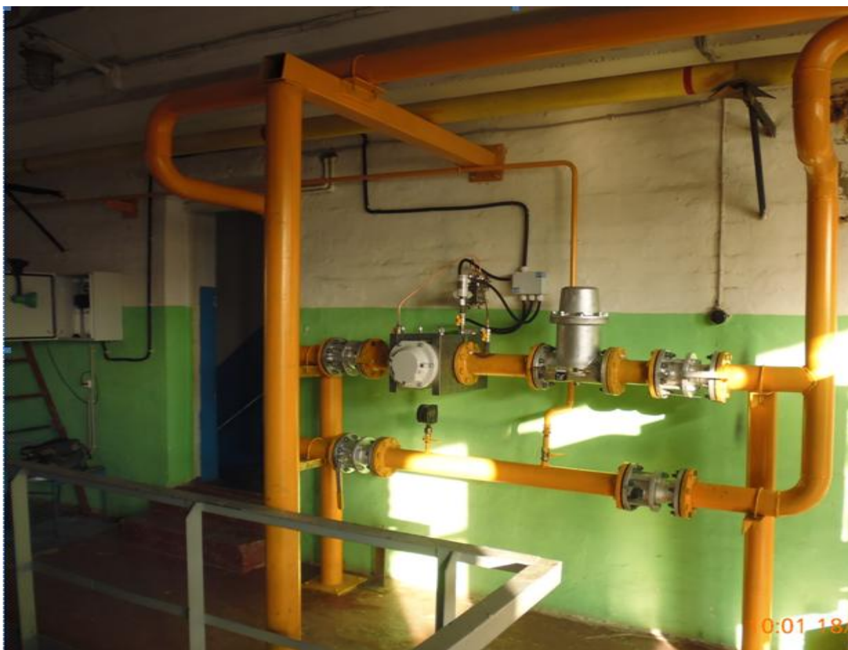
Техническое перевооружение узла учета газа на котельной по адресу: ул.Театральная,17
