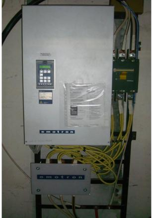
Произведена замена насосного и теплообменного оборудования, а так же установлены частотные преобразователи на сетевые насосы на котельной по адресу: Пл.Мира,6-к.
